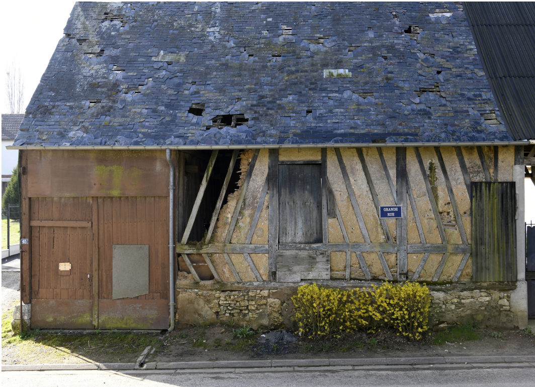
Ancienne grange sur rue, 1781, n°45 de la Grande Rue, vue depuis le nord.
