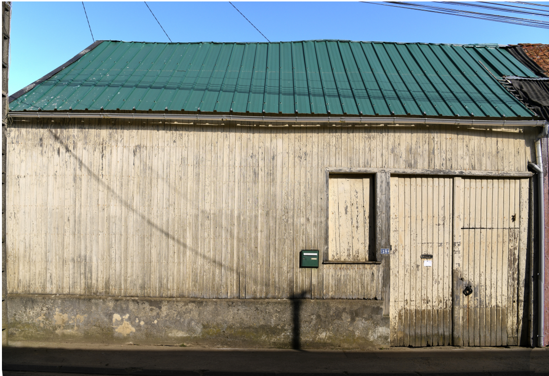
Grange avec porte à engranger couverte d'un essentage en clins, n°18 de la Grande Rue, vue depuis le sud.
