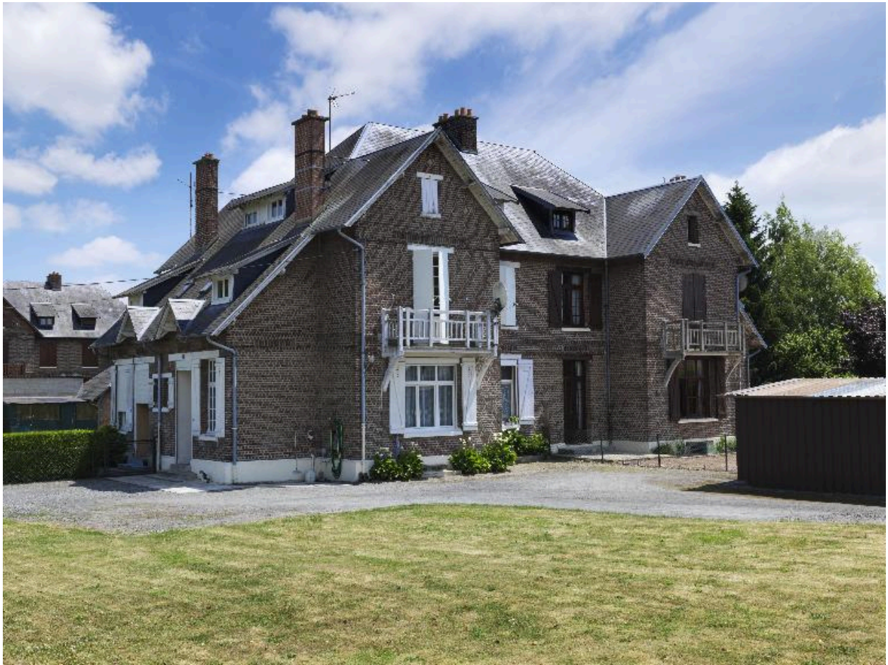
Maison ouvrière à quatre logements (29-31 avenue Germaine).
