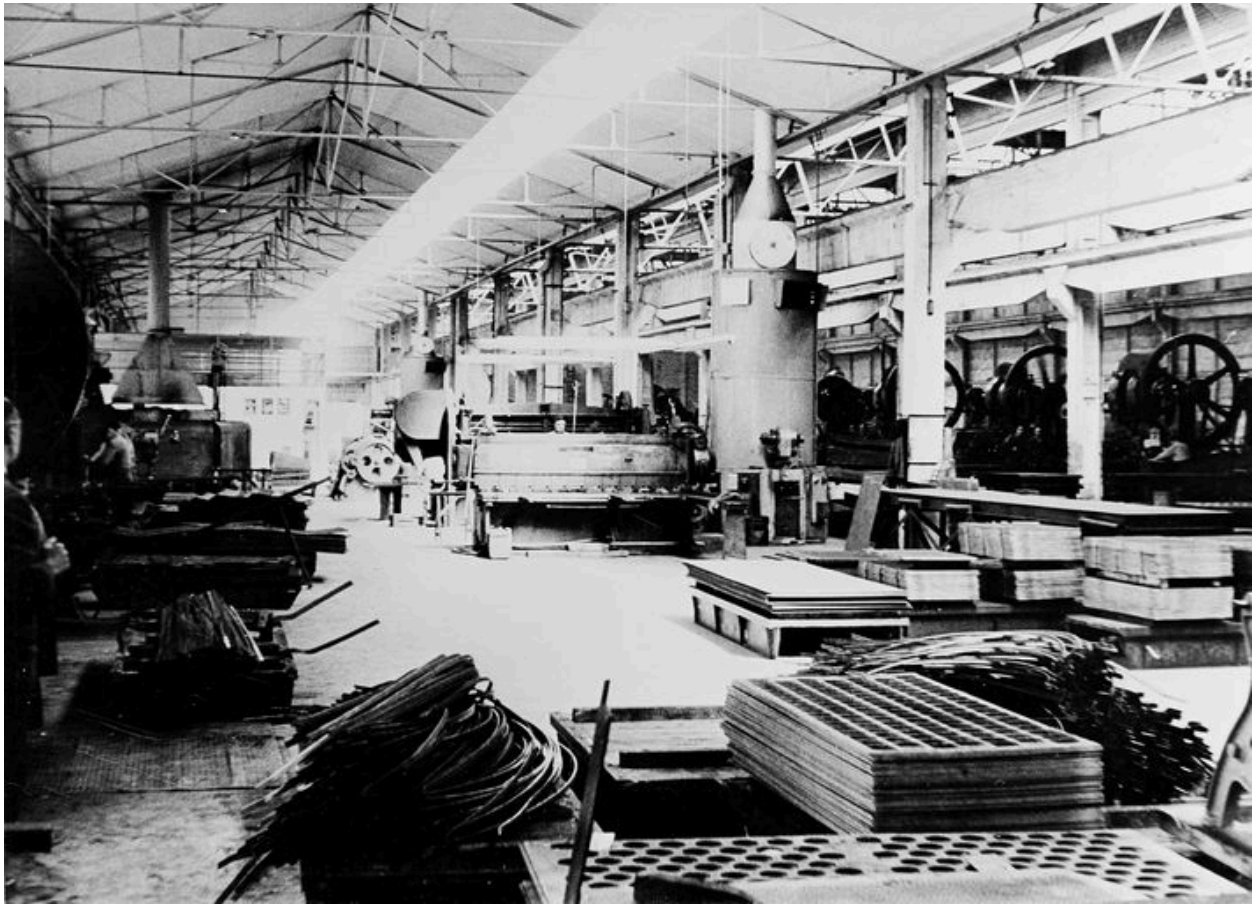
Atelier de fabrication : vue intérieure (AP).
