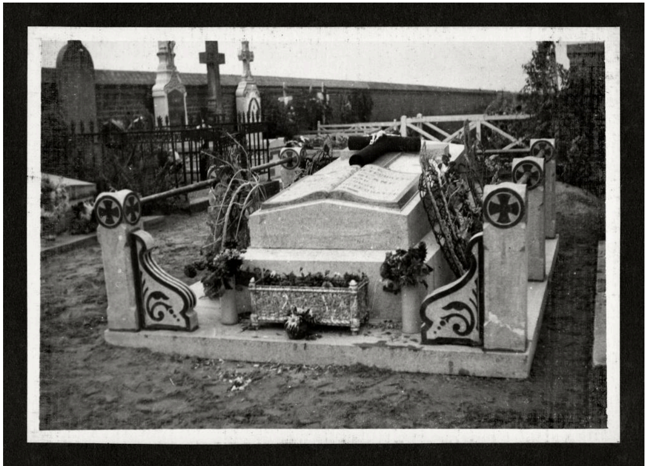
Tombeau élevé dans un cimetière non identifié de la Somme par l'entreprise Louis Timmerman. Photographie, vers 1930 (A.P. Drillancourt).
