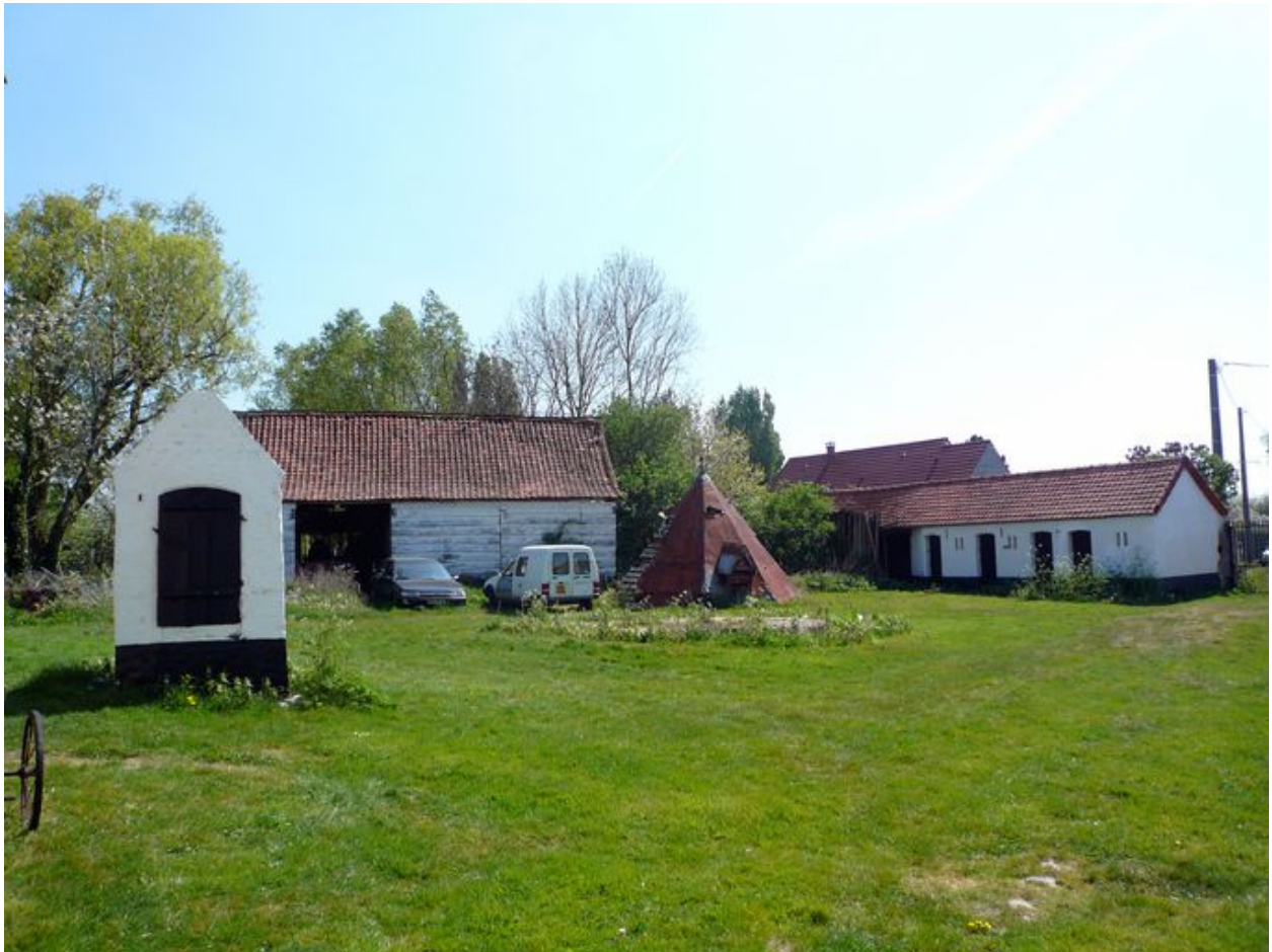
Vue des étables et de la charretterie au sud de la cour.
