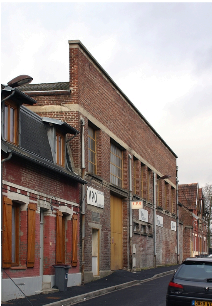
La centrale thermique vue depuis la rue Dornenberger.
