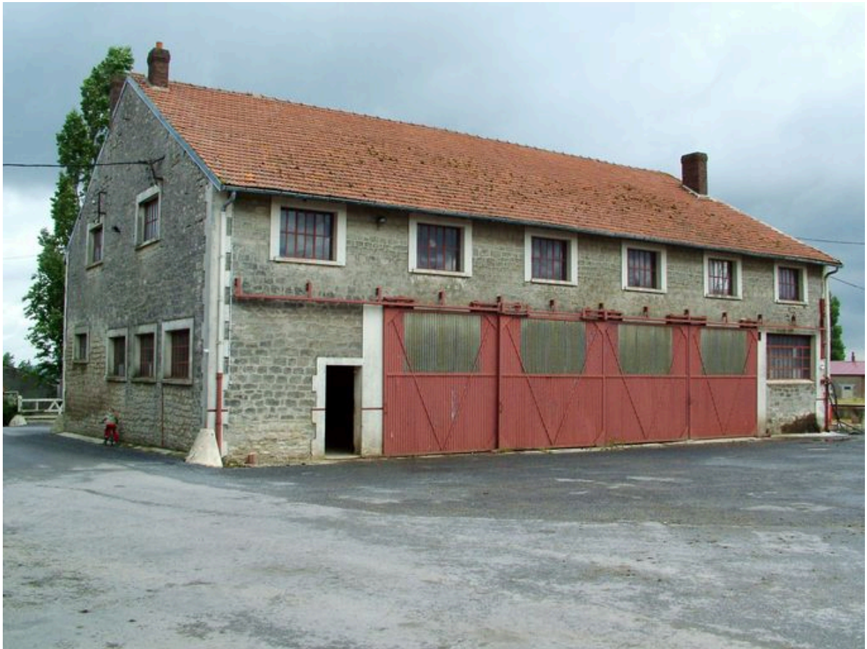
Vue d'un bâtiment agricole.
