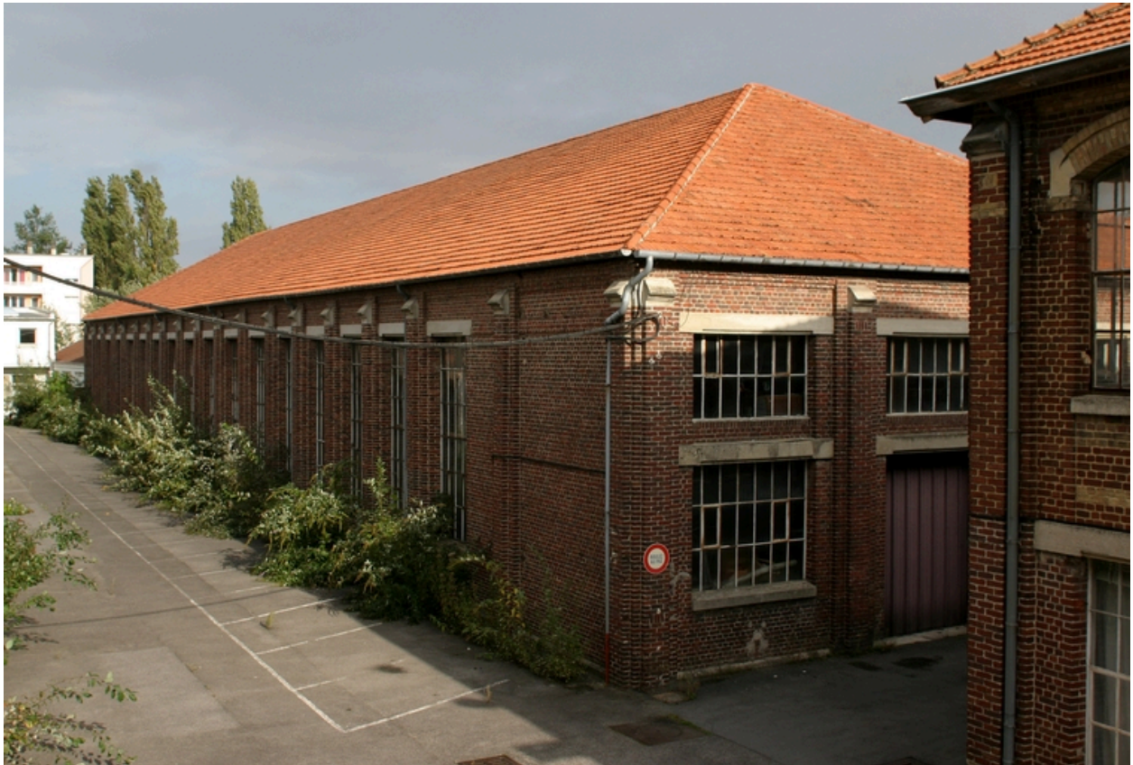
Façade ouest de l'un des deux grands ateliers de guipure reconstruits en 1919.
