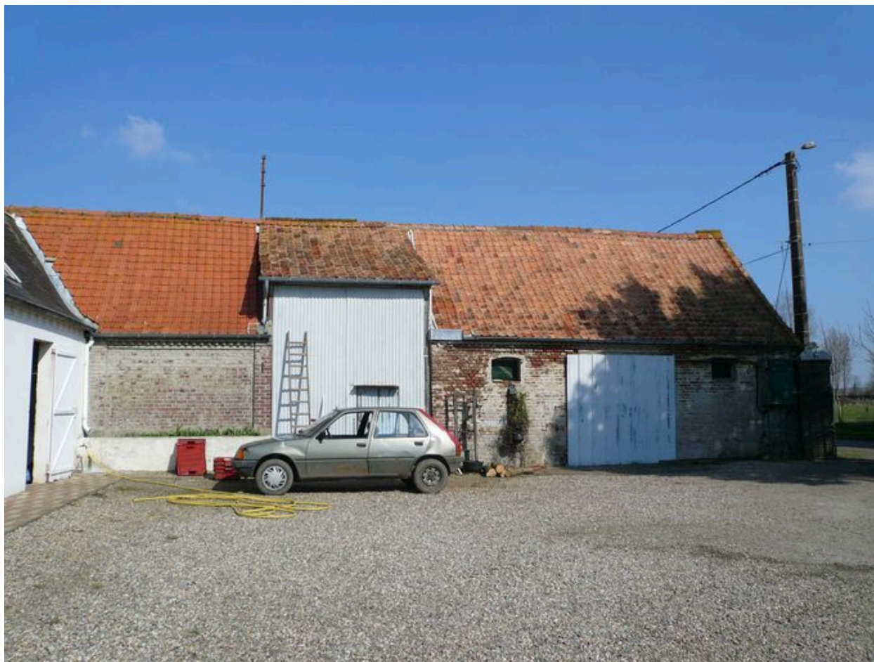
Vue de la grange depuis la cour.
