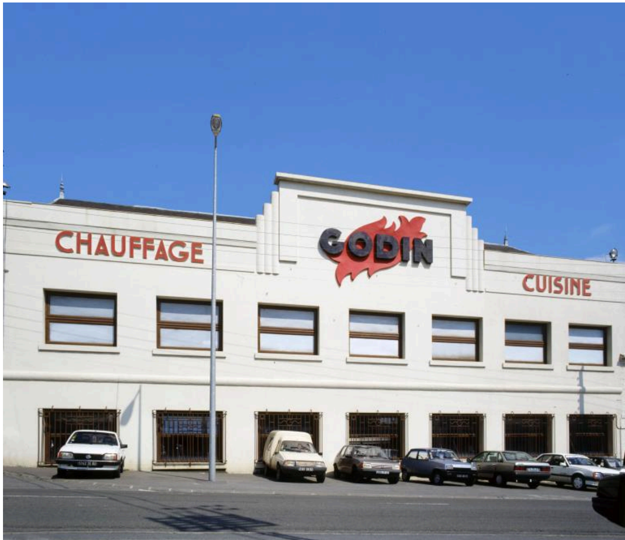
Vue de la façade sur rue d'un des bâtiments administratifs remanié dans les années 1920-1930.
