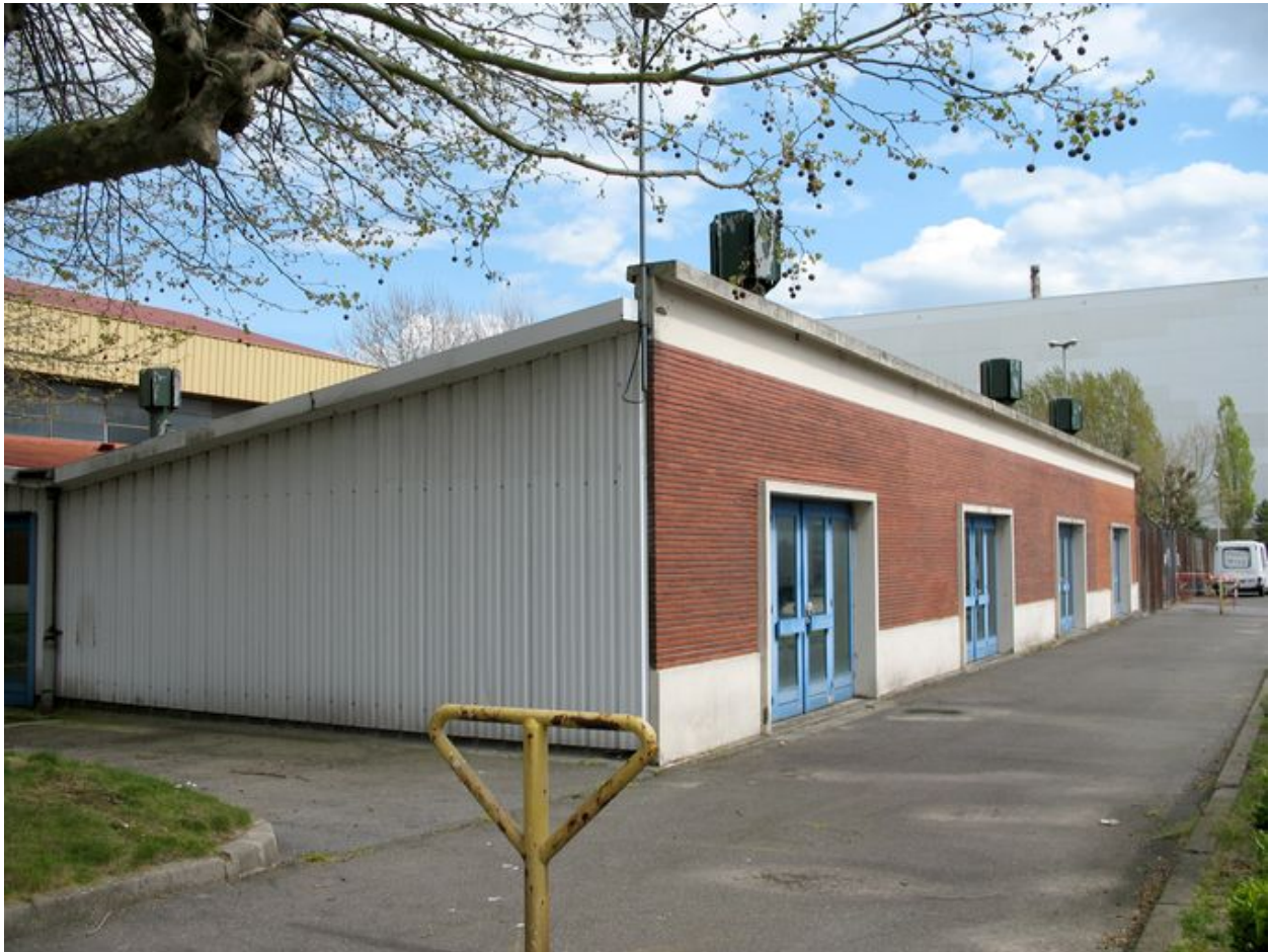
Garage à vélos construit en 1957 face à l'entrée de l'usine.
