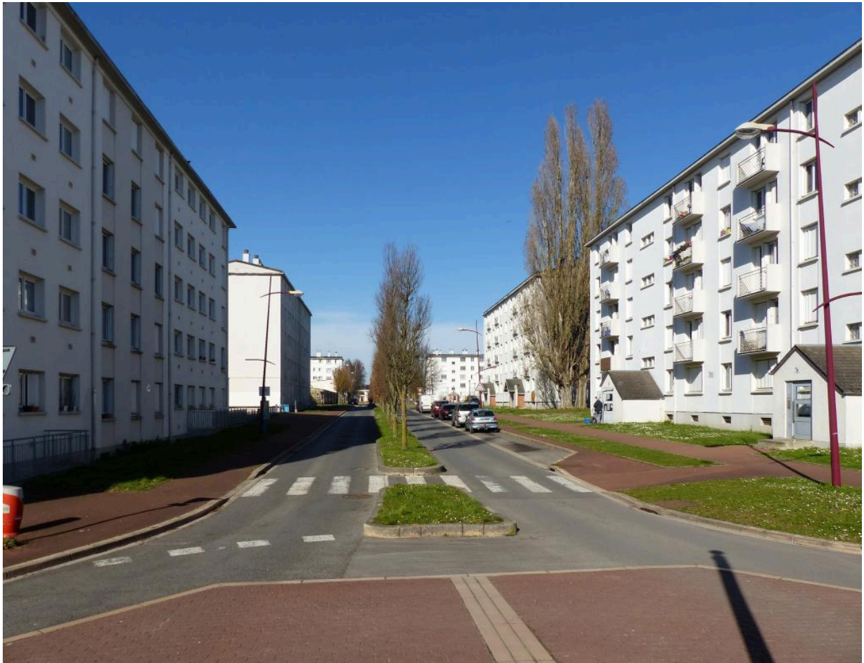
Le boulevard Roosevelt, vue vers le nord-ouest depuis le carrefour avec les rues de la Paix et Marcel-Paul.
