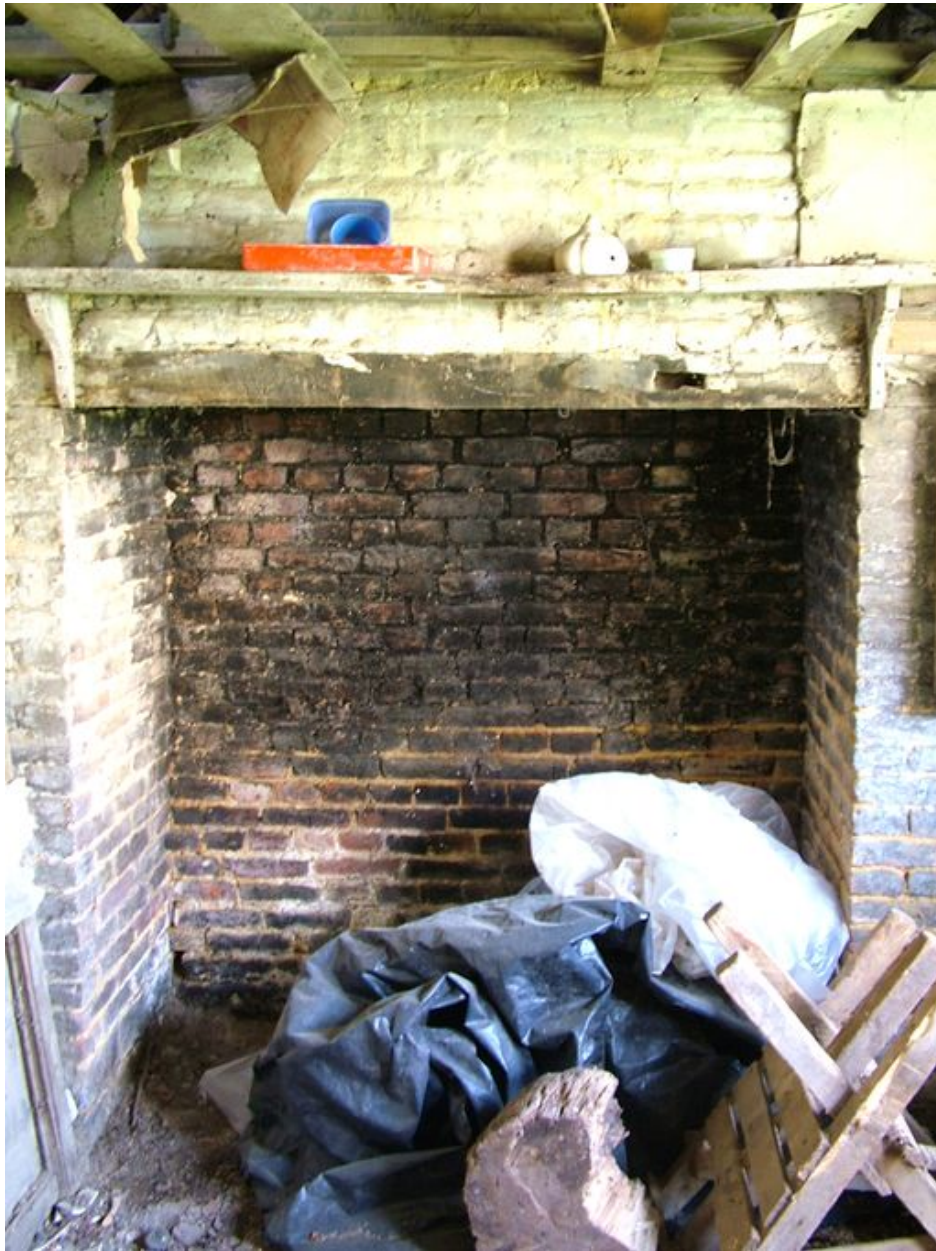
Cheminée du séchoir à chanvre.
