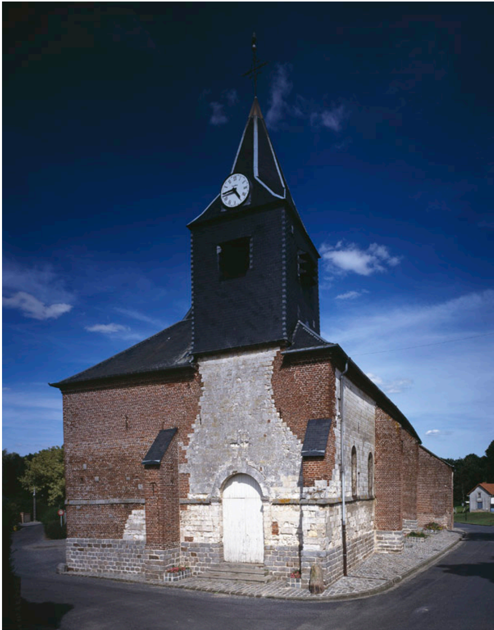
Vue de la façade occidentale.
