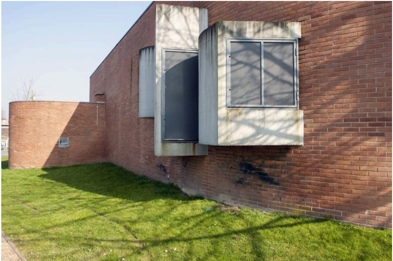
Vue en enfilade des verrières depuis l'extérieure.
