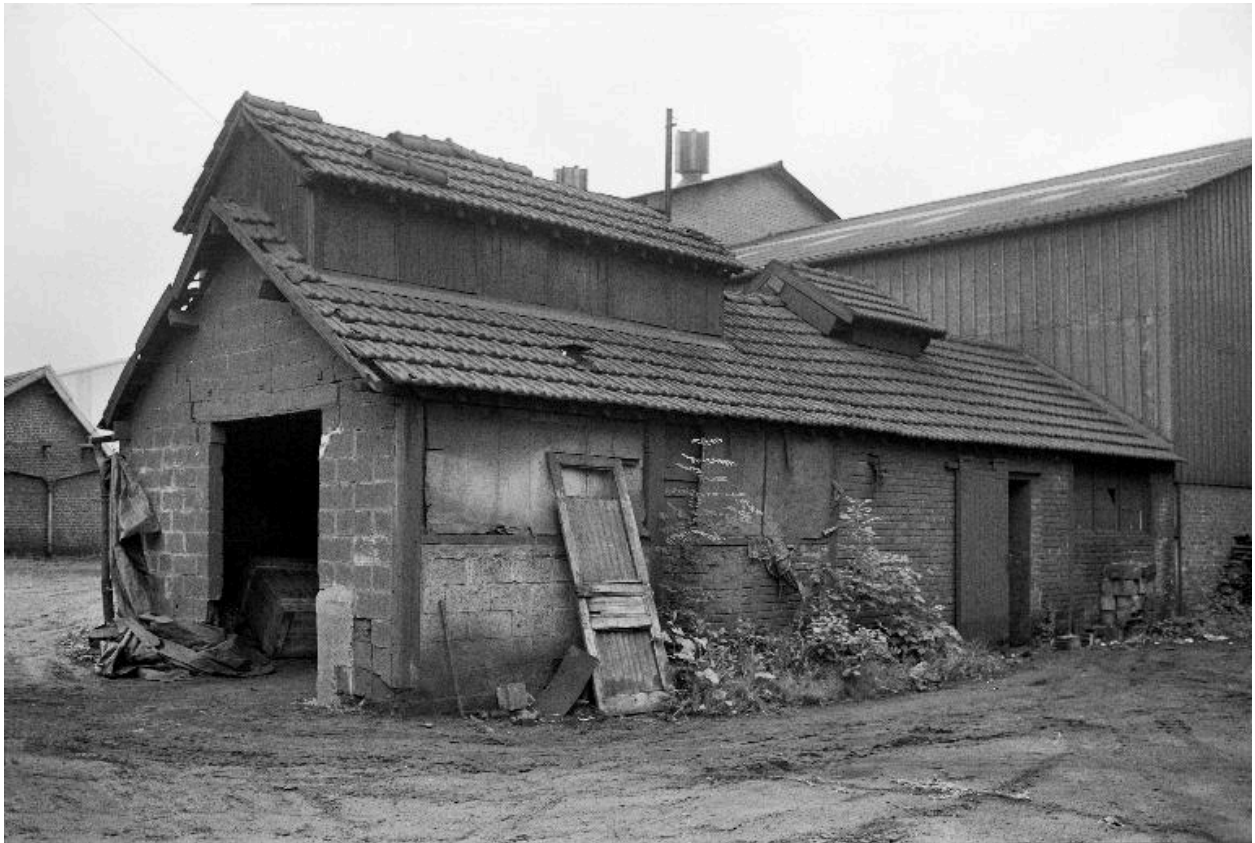
Atelier de fabrication, en 1990.
