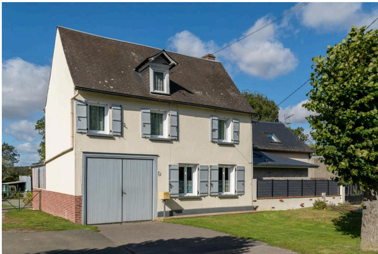
Logis sur rue, n°38 Grande Rue, vue depuis le sud-est.
