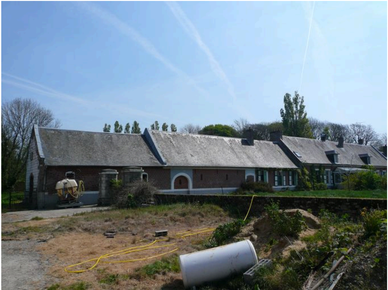
Vue des bâtiments situés dans le prolongement au nord du logis.
