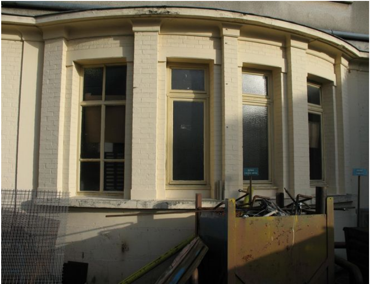
Détail des fenêtres du laboratoire.
