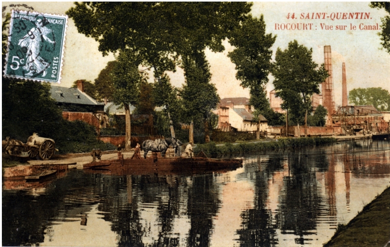
L'Usine de Rocourt vue depuis le Canal de Saint-Quentin vers 1900 (BM Saint-Quentin).
