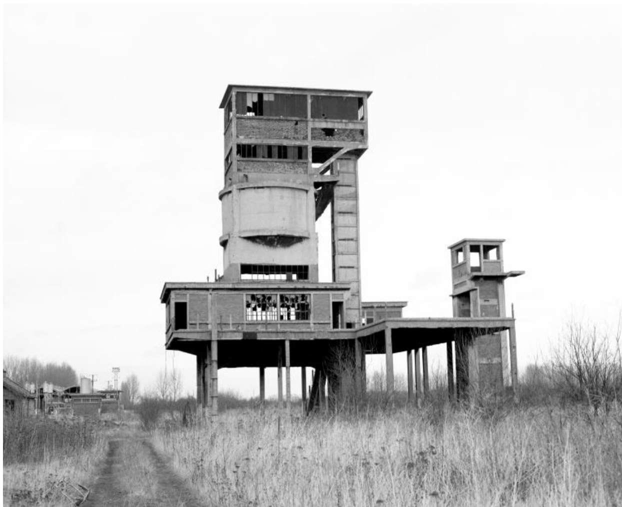
Toboggan à charbon, vue latérale (détruit).
