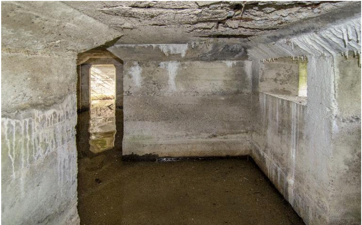
Vue générale, vers la sortie ouest. A droite le poste de tir et de surveillance
