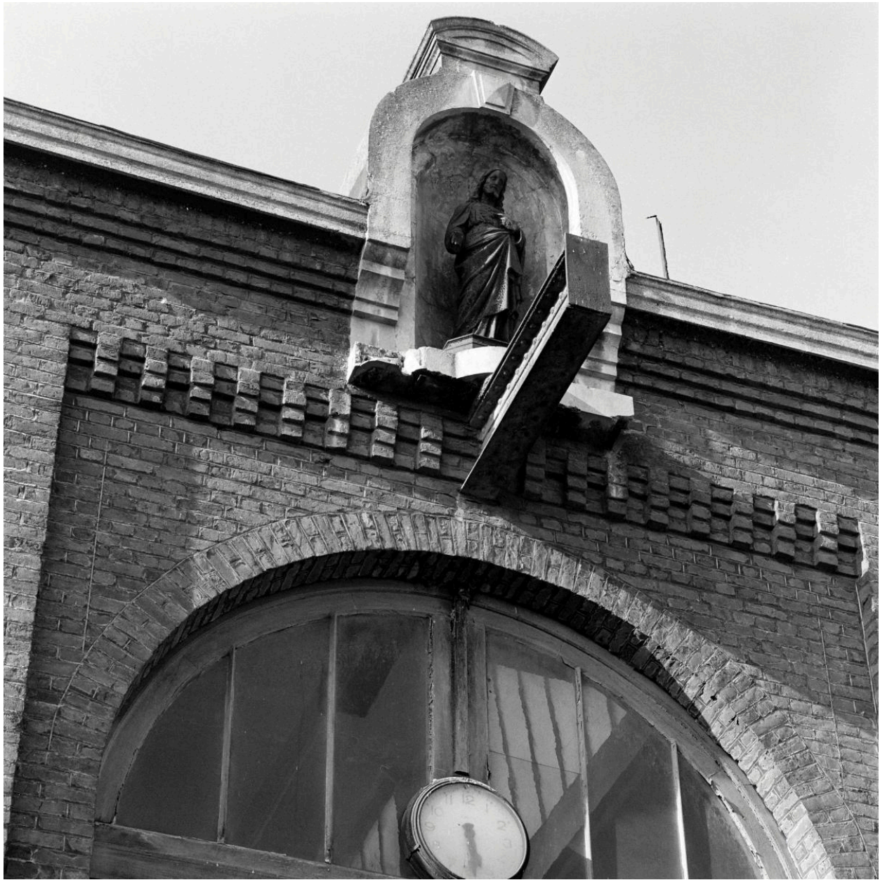
Salle des machines, élévation ouest, niche et statue du Sacré-Cœur.
