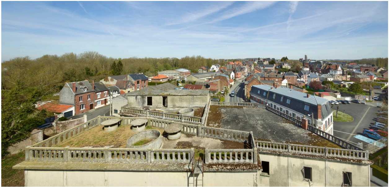
Terrasse des silos et magasins.
