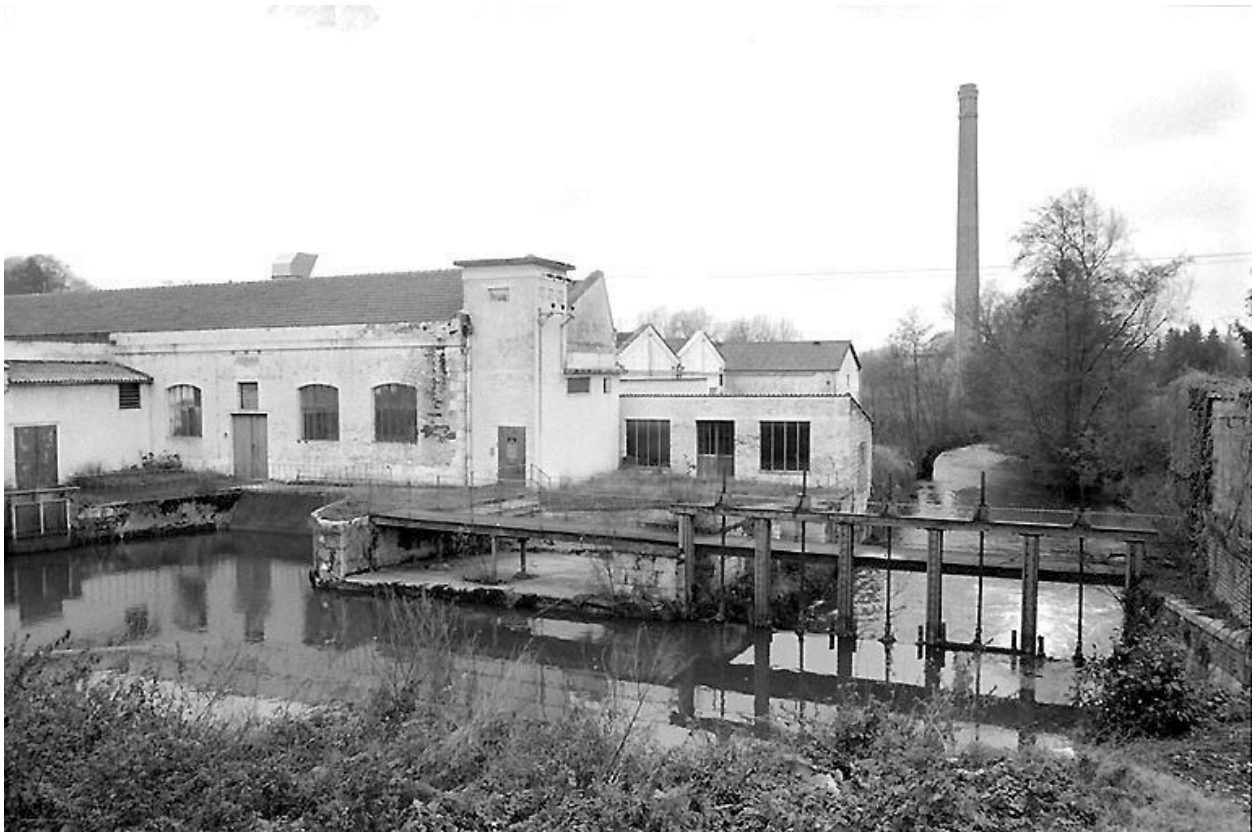
Centrale électrique, bassin de retenue et ponton du déversoir.
