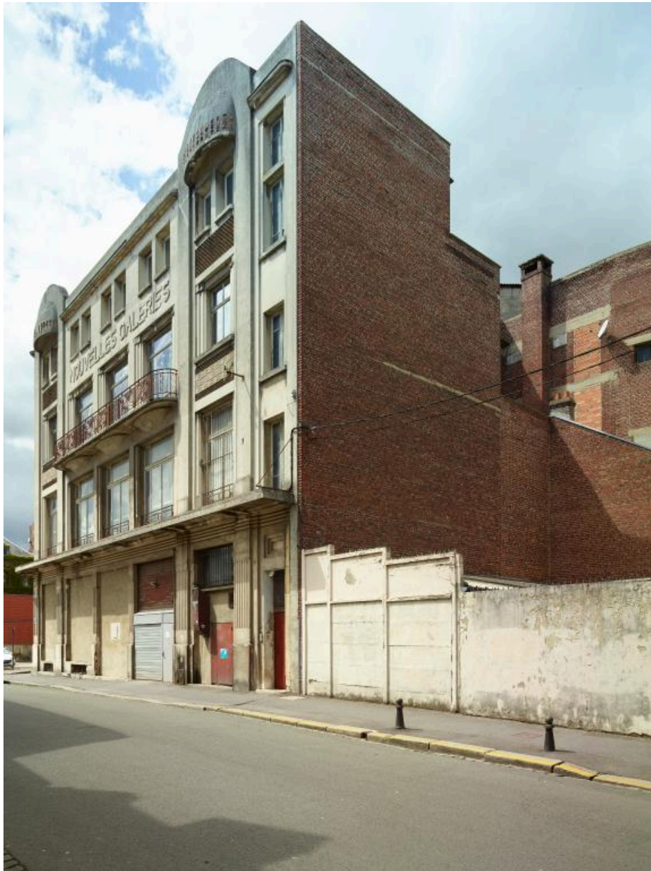
Façade sud des Nouvelles Galeries donnant sur la rue Anatole France.
