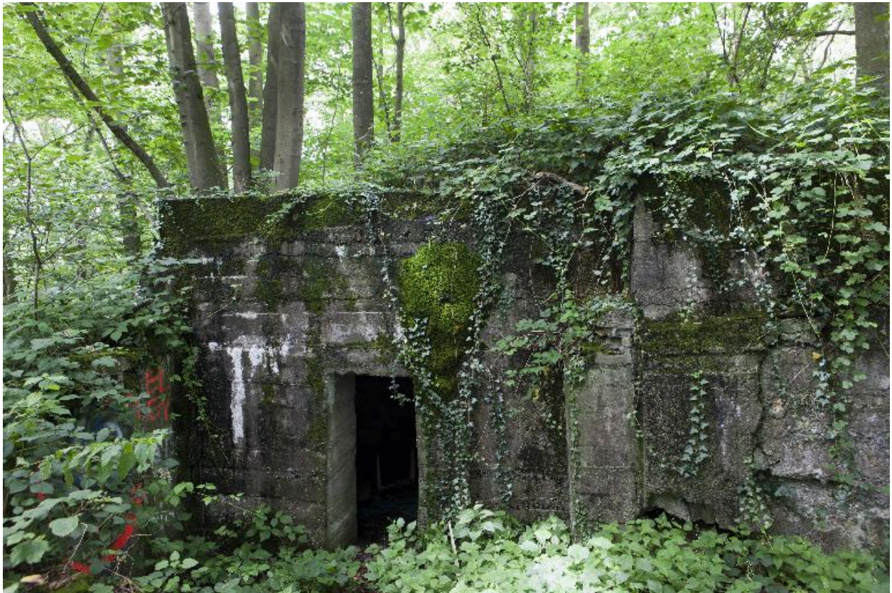
Casemate n°3, élévation antérieure, partie sud.
