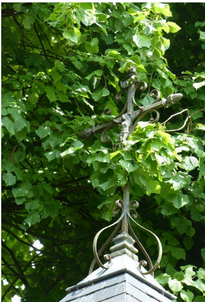
Vue de détail sur la croix couronnant la toiture.
