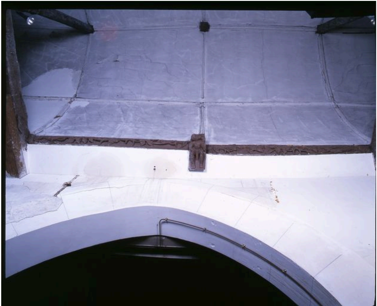
Vue détaillée d'une partie de la sablière basse du mur sud du bas-côté nord.
