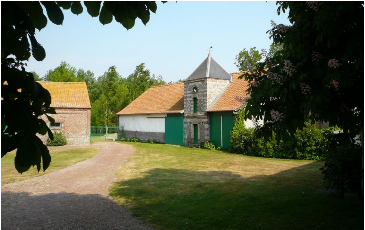
Vue de la grange avec pigeonnier intégré depuis la cour au sud de celle-ci.
