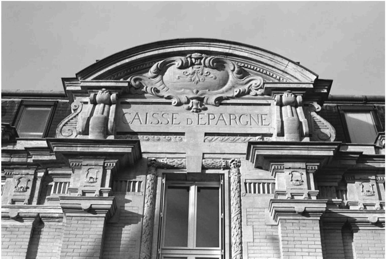
Détail du fronton cintré.
