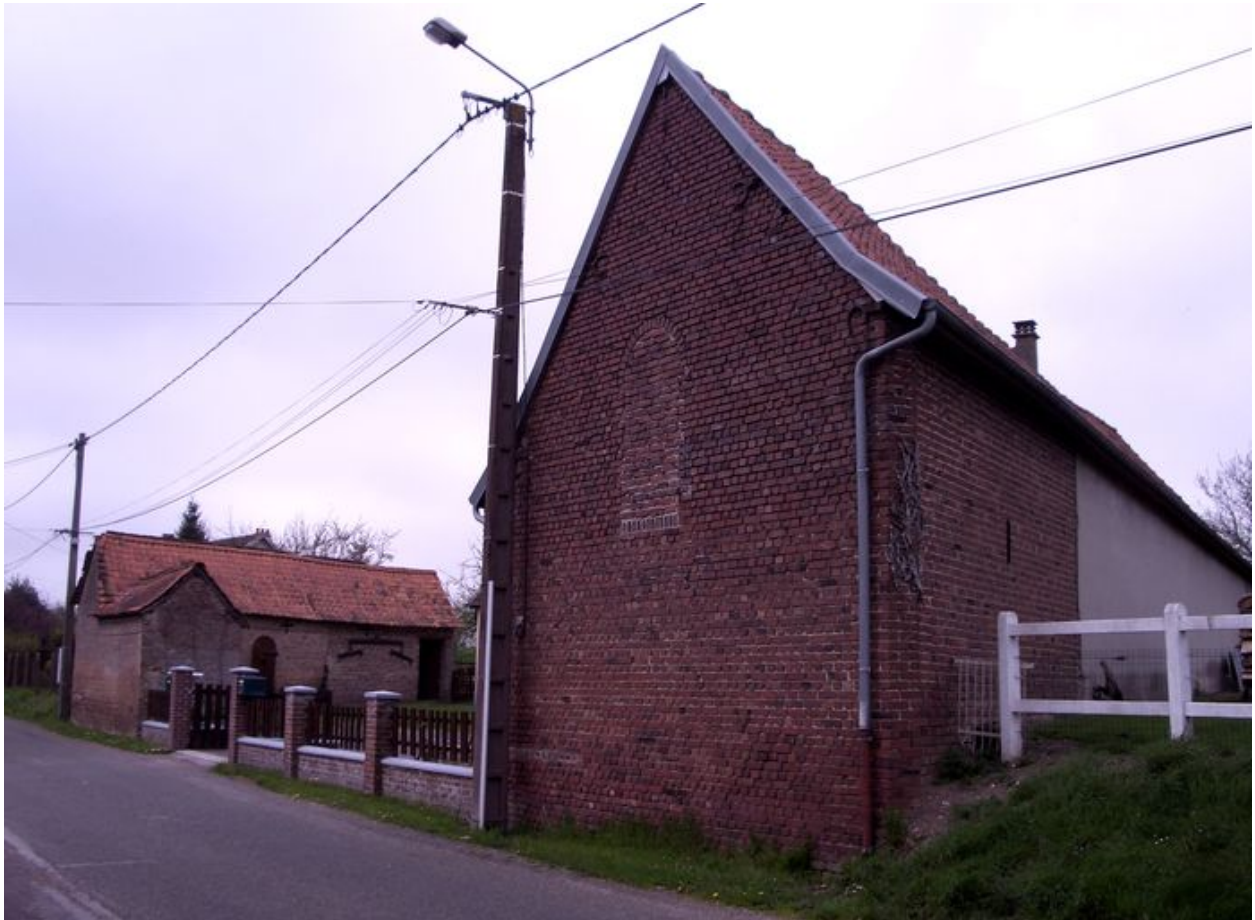
Vue du mur pignon de l'ancienne grange.
