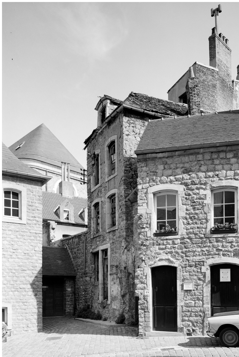
Façade sur voie avant restauration.
