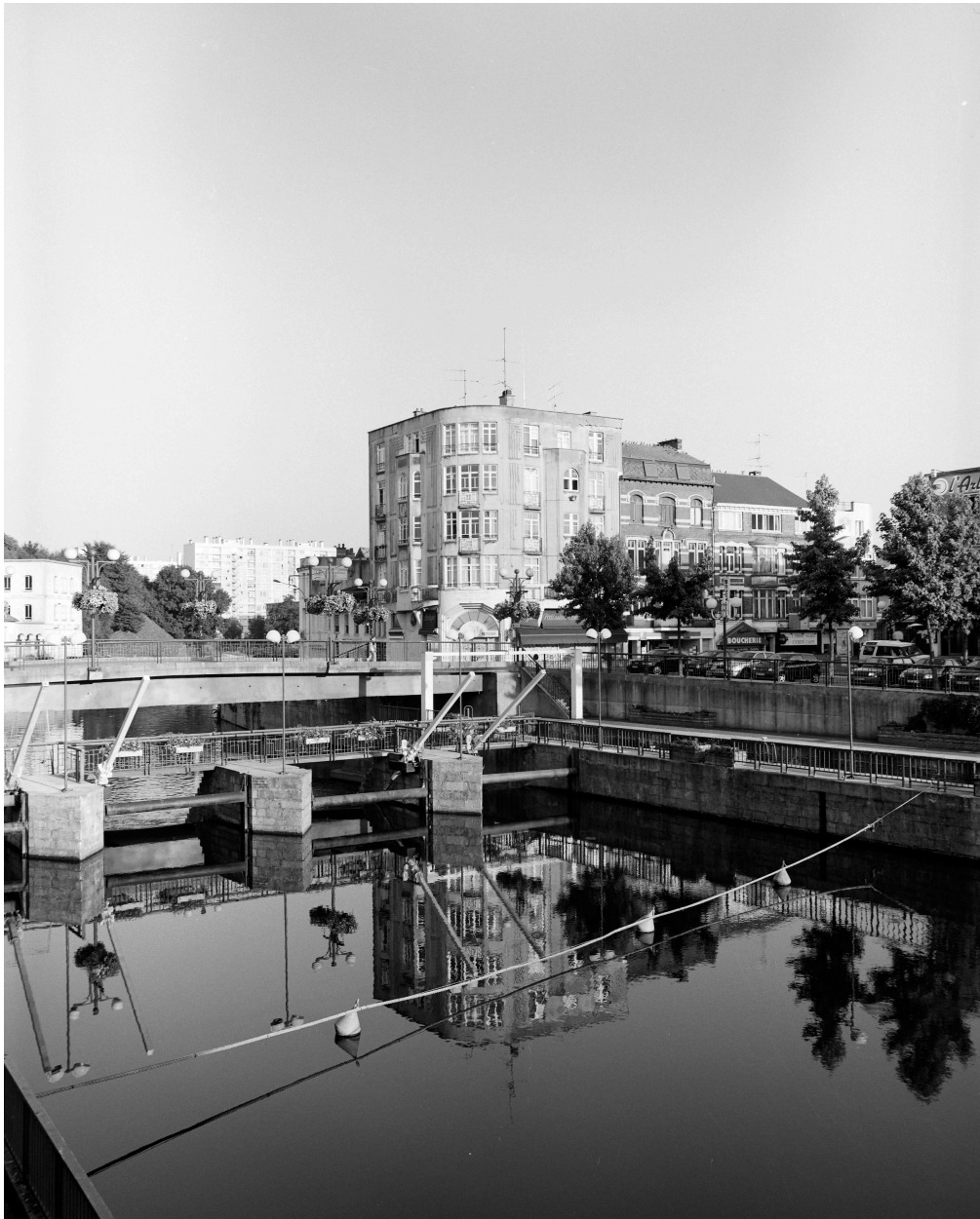
Vue générale du paysage urbain dans lequel s'inscrit l'immeuble Lecluyse.
