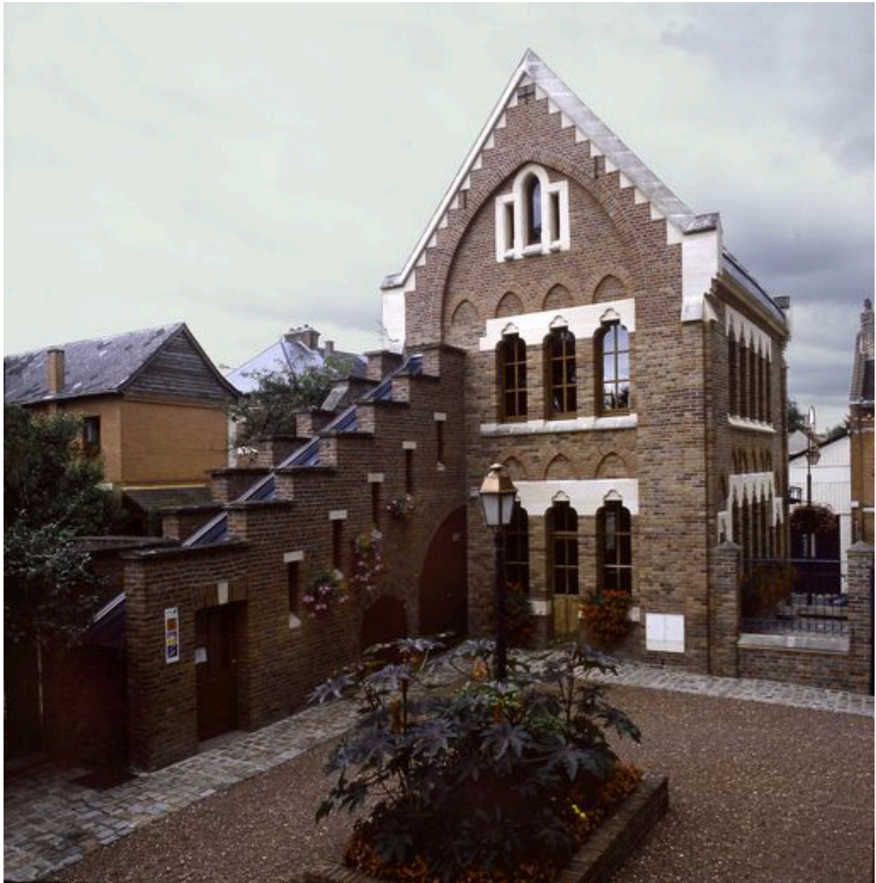
Vue depuis la cour.
