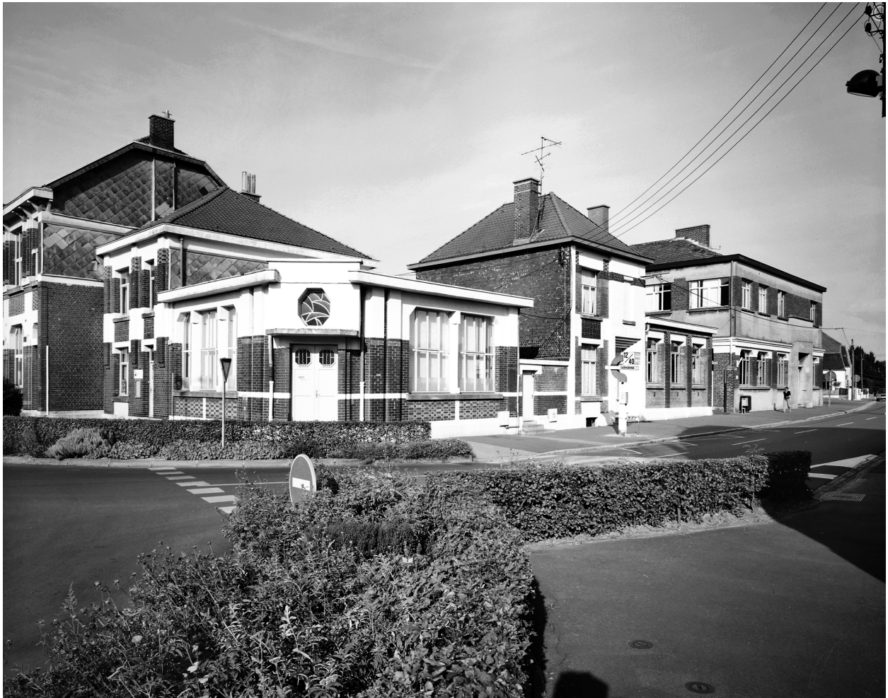
École de Feignies construite par l'architecte Adolphe Danis (1886-1969) en 1928.
