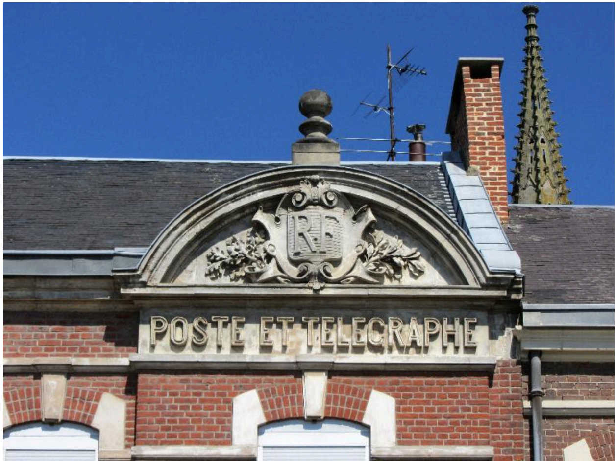
Détail du fronton de la façade sur rue.
