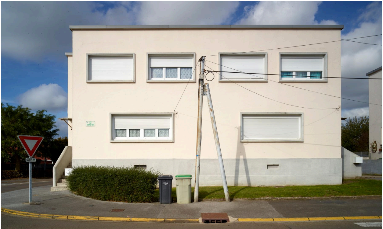
Vue des pavillons situés aux extrémités de l'opération (bloc C), prise depuis la rue.
