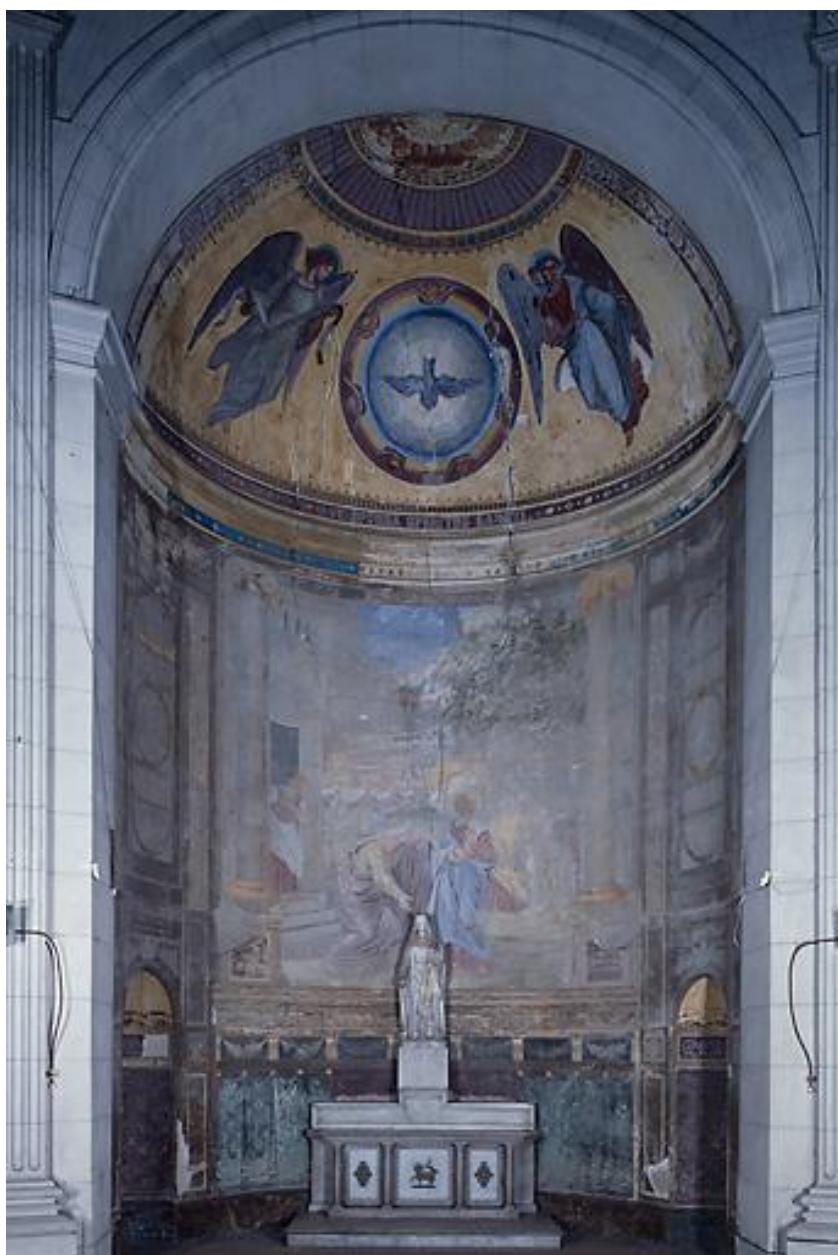
Vue générale avant restauration.
