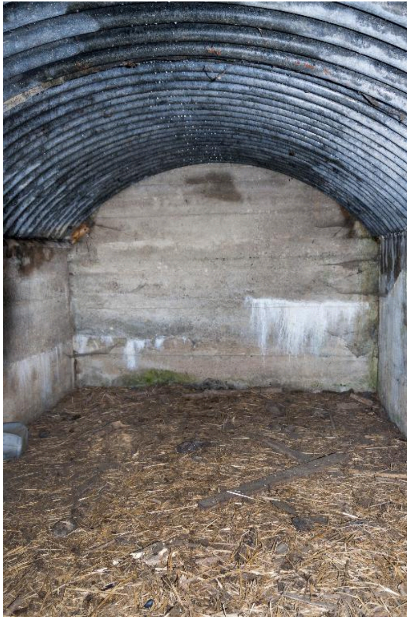
Casmate b. Vue intérieure de la voûte en tôle "métro"
