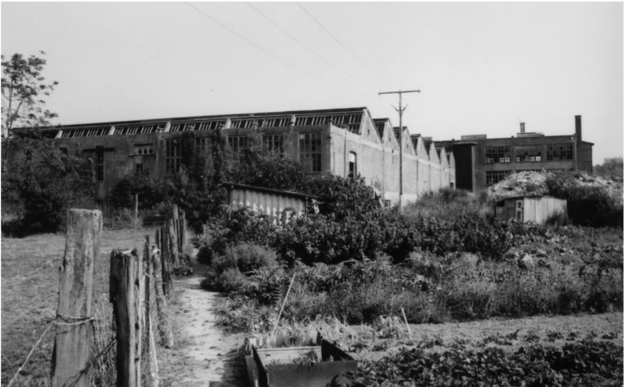
Atelier de fabrication (tissage), flanc sud-ouest.
