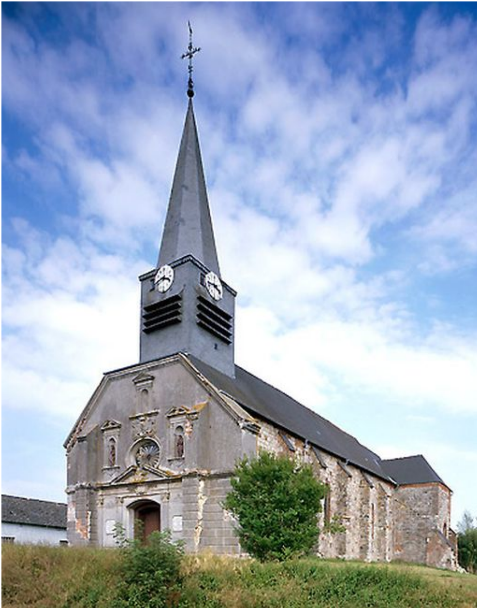
Vue générale depuis le sud-ouest.
