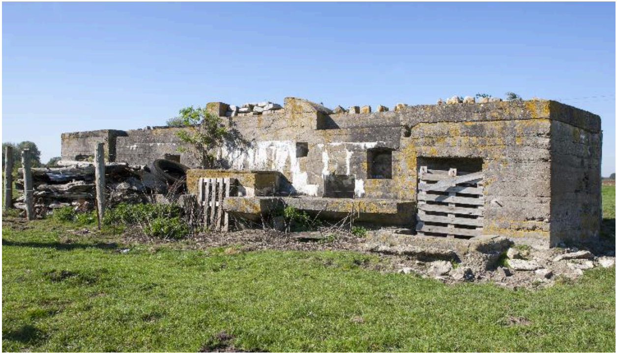
Elévation sud, vers le nord-ouest
