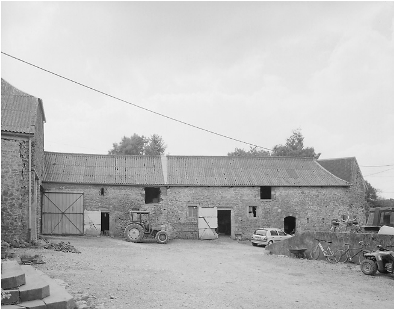
Vue des étables-fenil, contigus à la grange.
