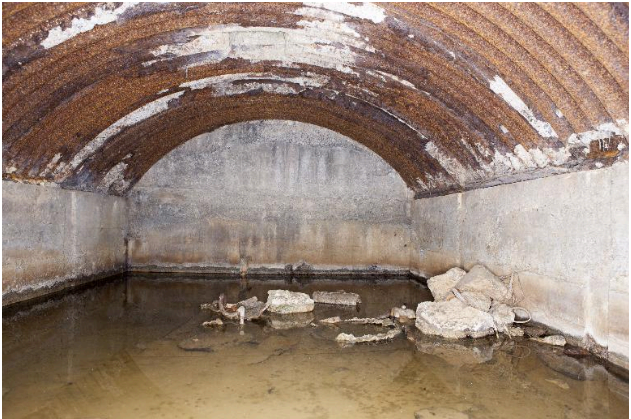
Vue intérieure vers le nord-ouest
