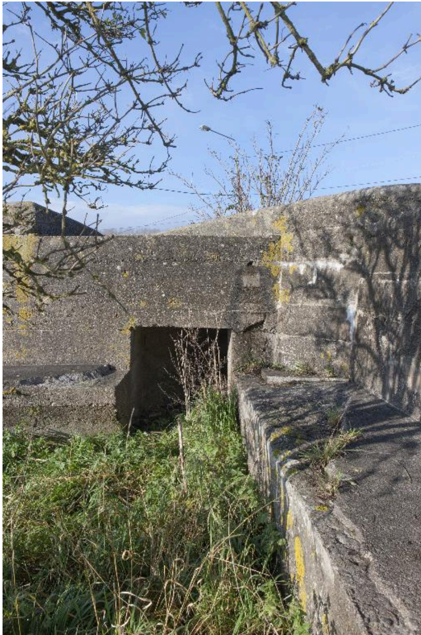
Accès pare-souffle à l'entrée ouest
