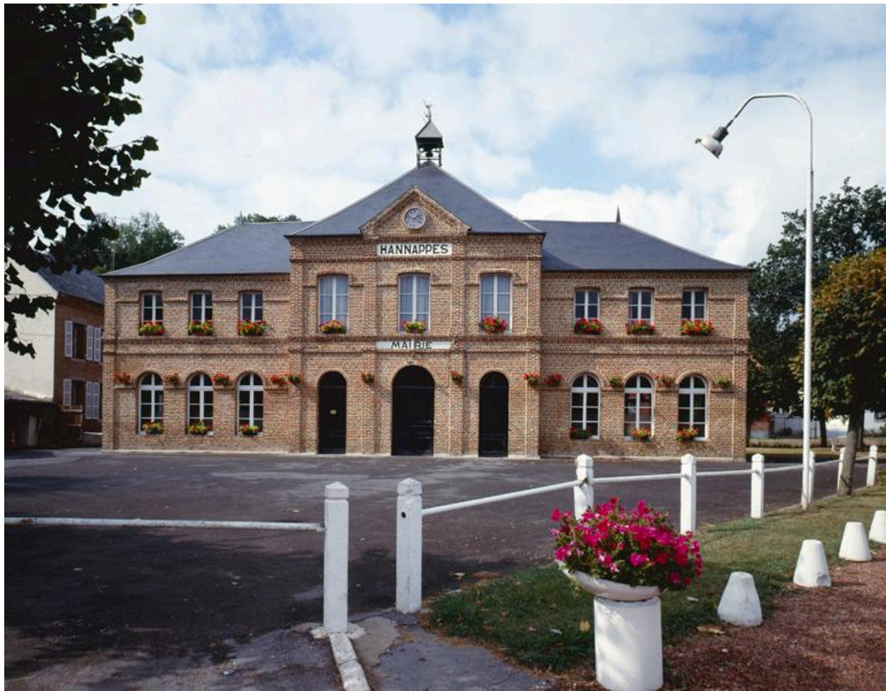
Vue d'ensemble de la façade.
