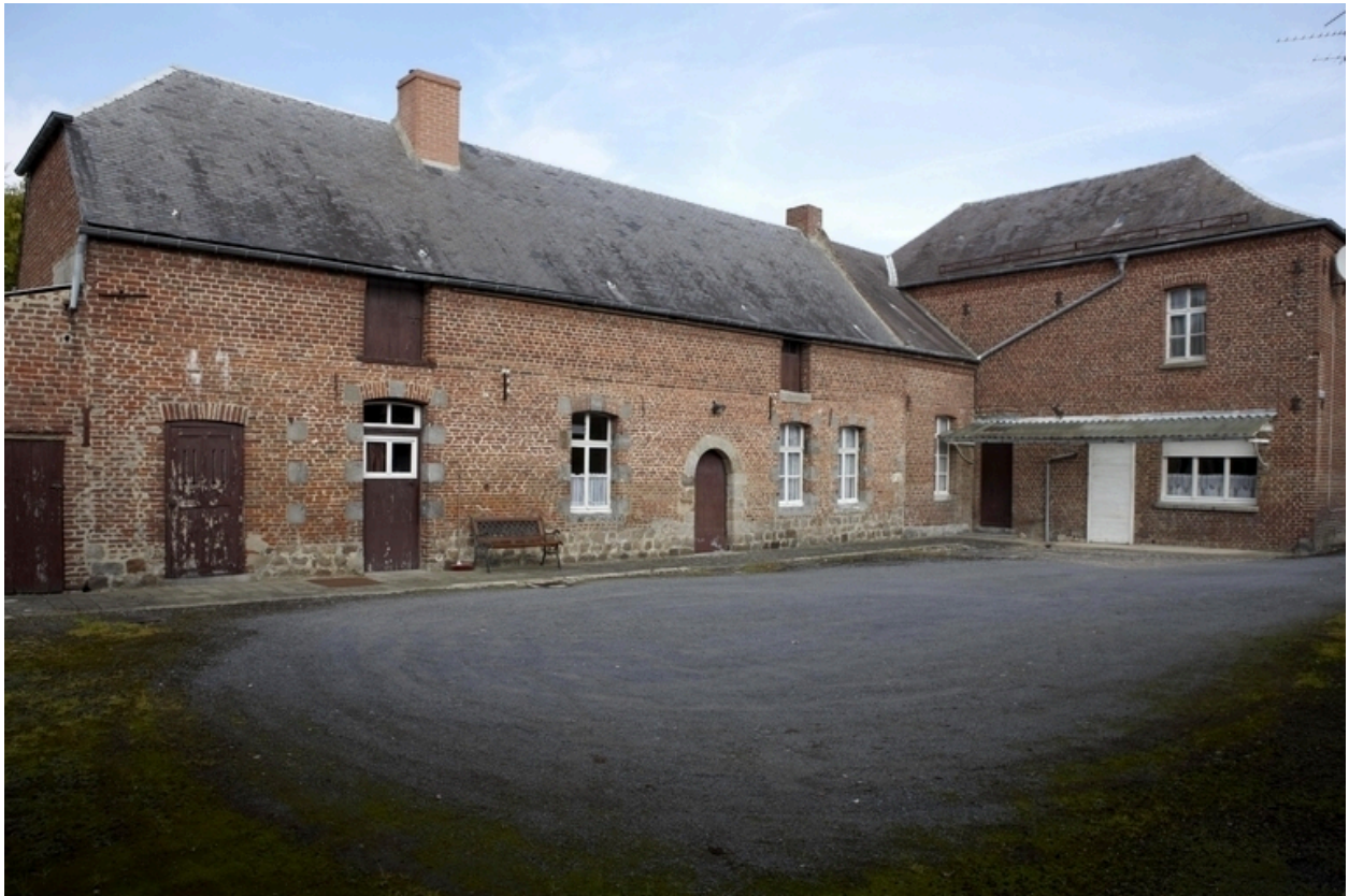
Vue générale du premier logis et du revers du logis sur rue.
