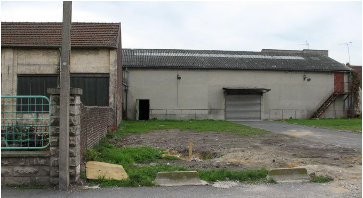
Façade nord-ouest remaniée.
